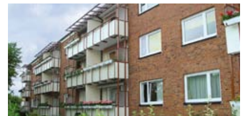
Billrothstraße 3-3b: 1. Abschnitt äußere Modernisierung
