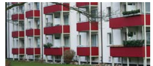
Geplant: neue Treppenhausestriche in der Wohnanlage Knud-Rasmussen-Straße 17-33.
