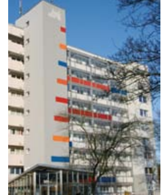
09.02.2012: Abschluss des 4. Bauabschnittes – Vorderansicht der Fregattenstraße 30.
